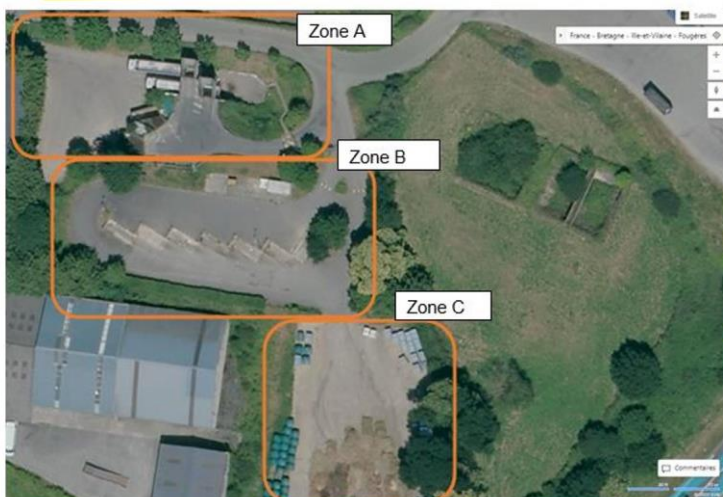
Vue aérienne du quai de transfert de Fougères
