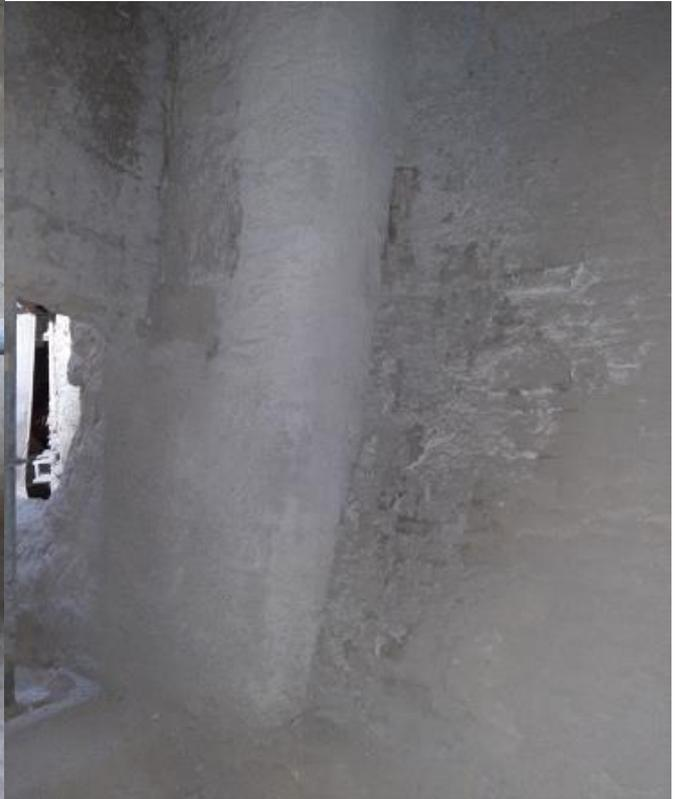
Pose de nouveaux ancrages et d'isolant en PC
