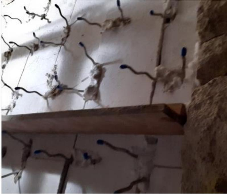
Remise à neuf du béton réfractaire au niveau du passage de gaz, portes PC
